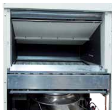
Заслонка кондиционера с фрикулингом для телекоммуникационного оборудования (мобильная связь)
